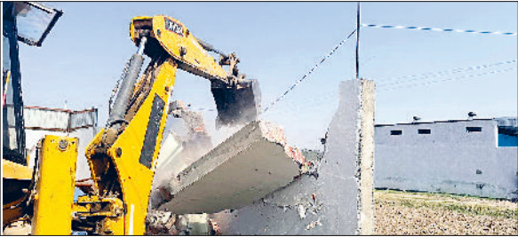
अंबाला। अवैध निर्माण को ढहाती जेसीबी।
